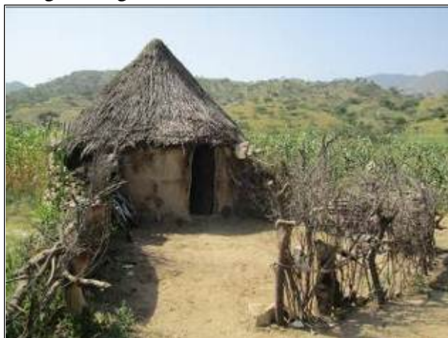
Figura 21 – Tukul: abitazione tradizionale tigrè
