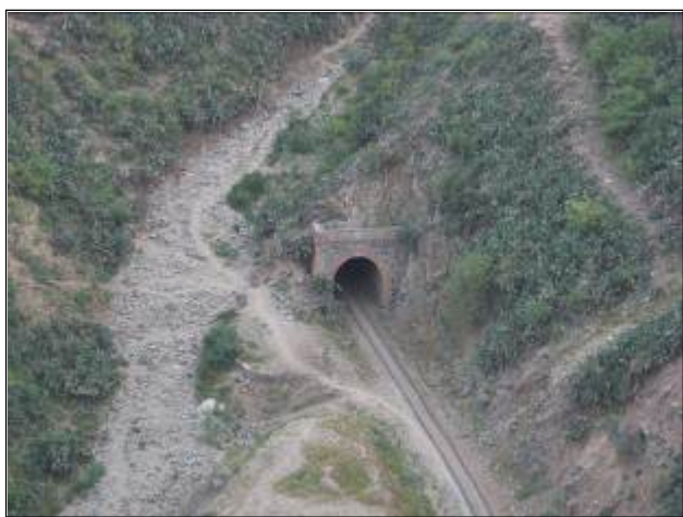
Figura 28 – Gallerie della ferrovia che collega Asmara e Massawa
