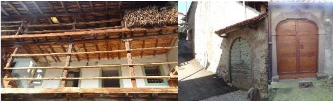
Figura 35 - Loggiati in abete (a sinistra) e antichi portali (a destra) nel centro storico
