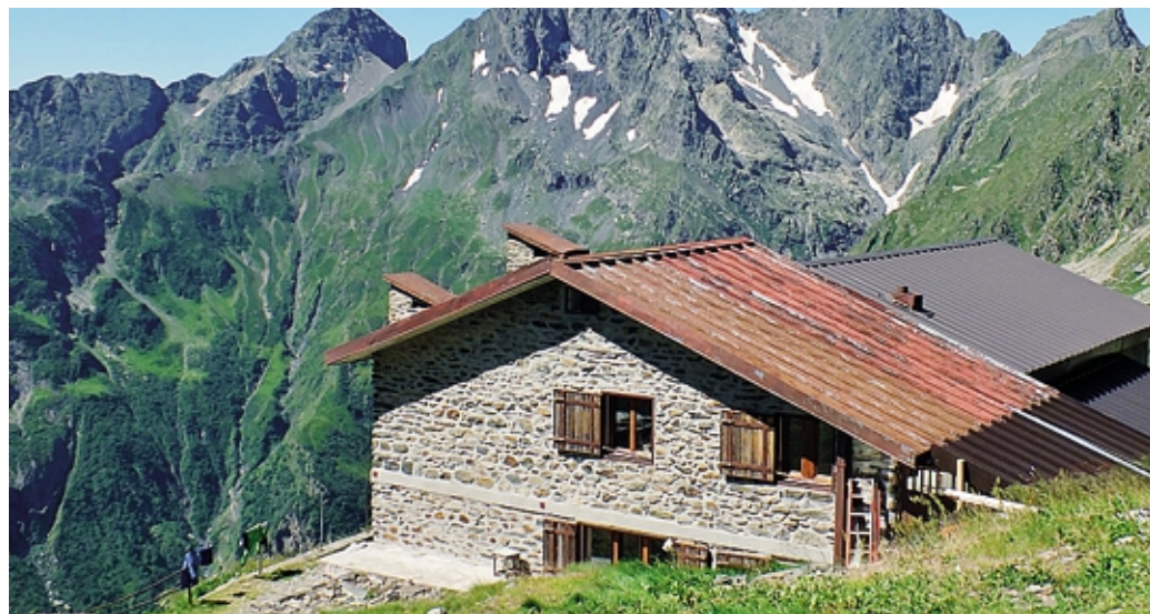
Il rifugio Brunone, sopra Valbondione
